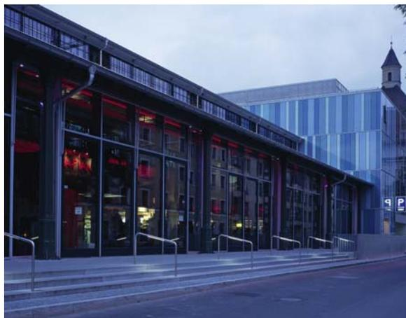
verglaste Fassade der Schrammenhalle mit Glaskaltfassade am anschließenden Neubau
